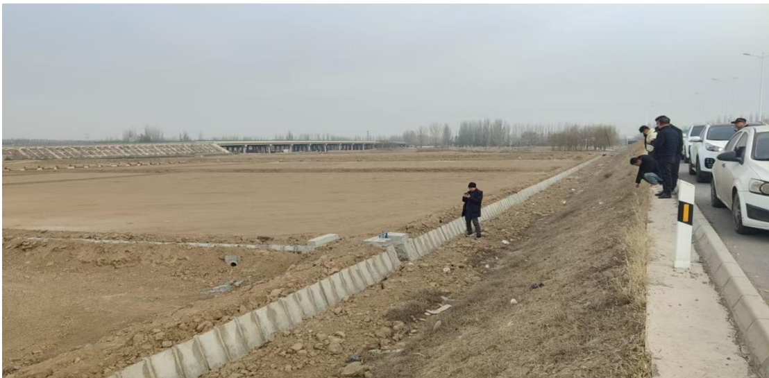
五渠砌护工程
